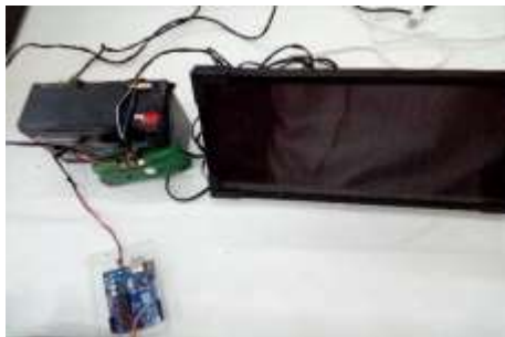
Figura 12. Sistema fotovoltaico responsable del funcionamiento del microcontrolador Arduino UNO
